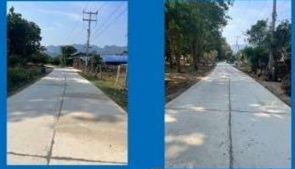
ภาพถ่ายหลังดำเนินการ
