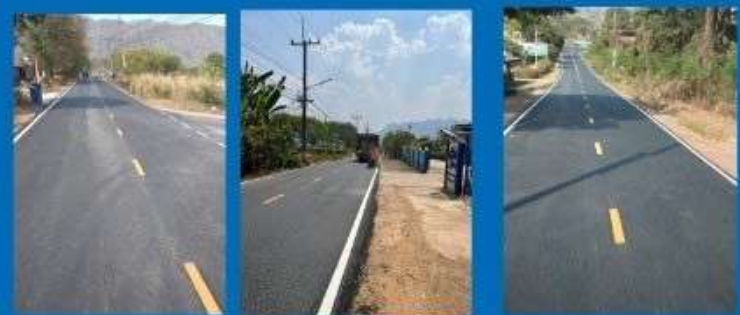
ภาพถ่ายหลังดำเนินการ
