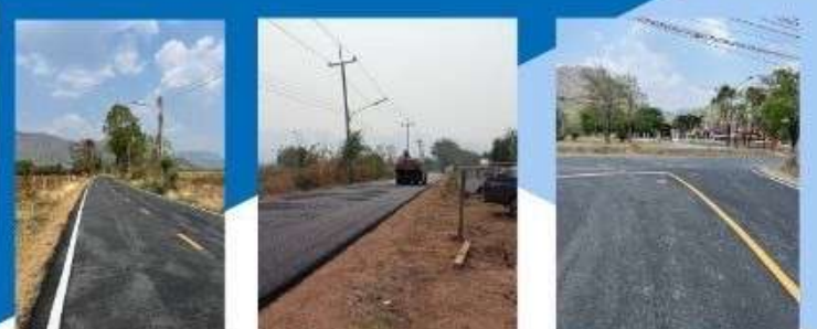
ภาพถ่ายหลังดำเนินการ
